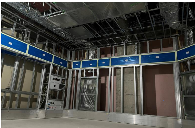
写真⑪(内装工事 手術室内装工事施工状況)
