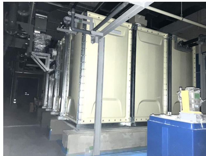
写真⑭(機械工事 透析排水処理設備施工状況)
