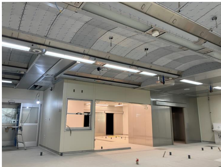
写真⑬(機械工事 天井換気システム施工状況(厨房))
