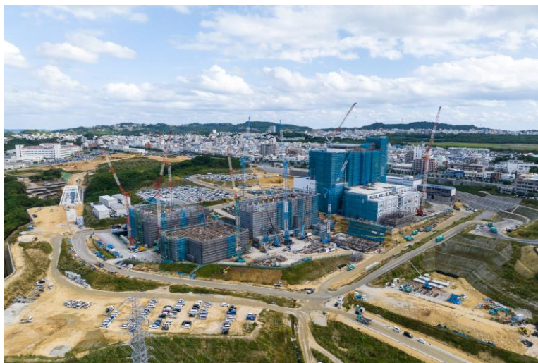
写真⑦(北西側)
