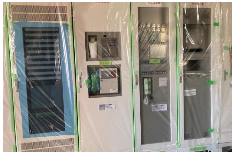
写真⑮(電気工事 防災盤取付状況(防災センター))
