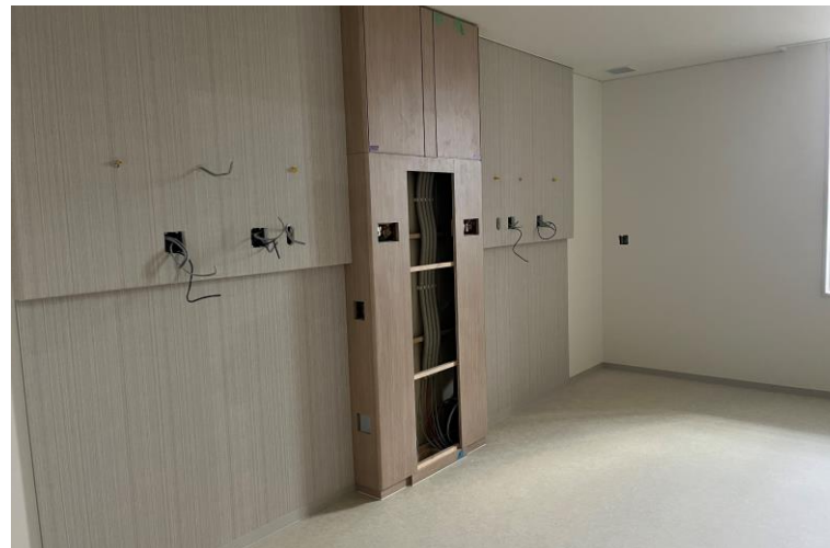
写真⑫ (家具工事 病室家具施工状況)
