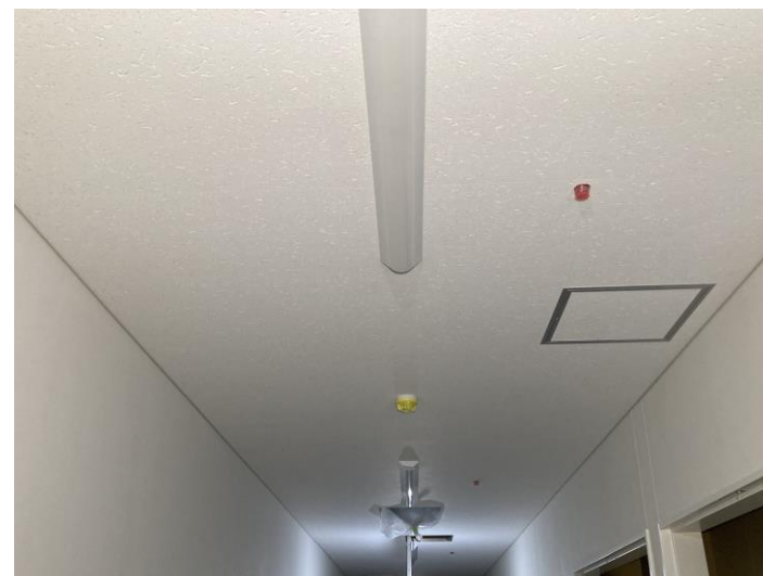
写真⑭(電気工事 4階廊下 器具取付状況)
