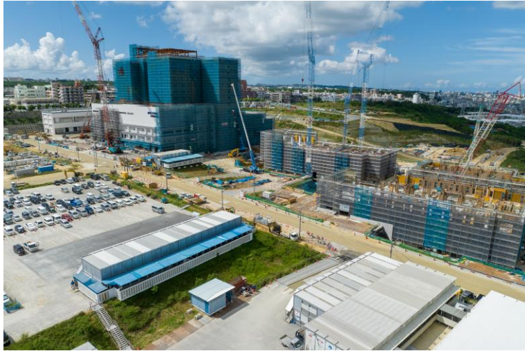
写真⑨(北東側)
