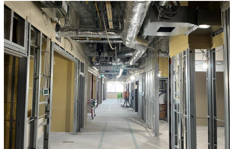
写真⑫ (内装工事 8階病棟廊下施工状況)
