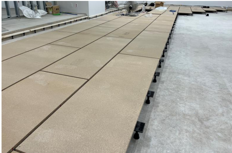
写真⑪(内装工事 1階薬剤部 二重床仕上工事施工状況)
