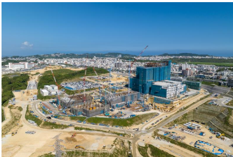
写真⑦(北西側)
