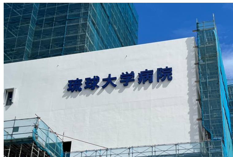
写真⑫(外壁サイン工事施工状況)
