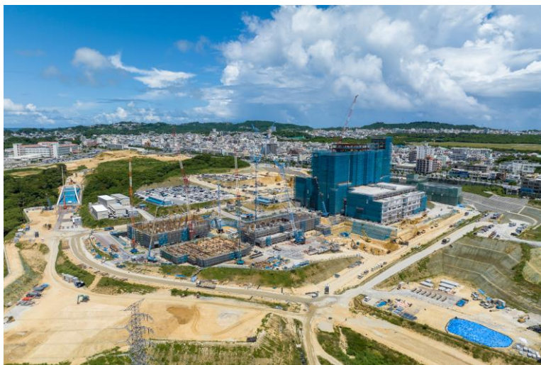
写真⑦(北西側)
