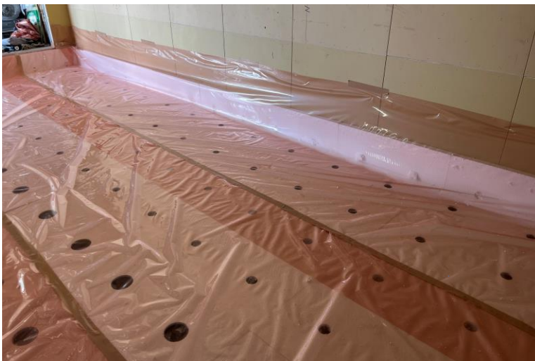
写真⑪(1階MRIシールド工事施工状況)
