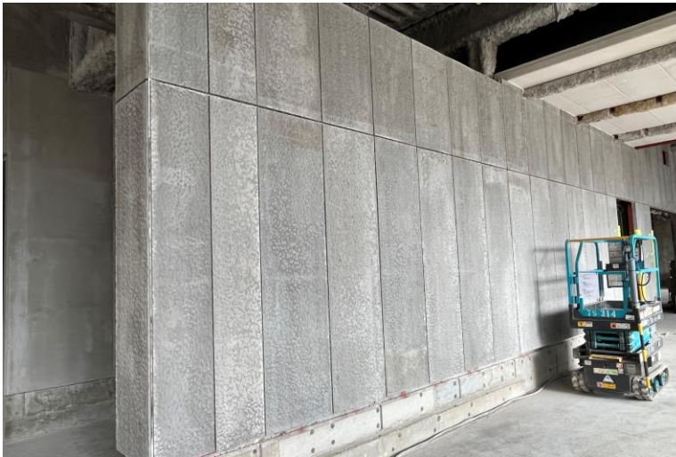
写真⑪(押出成形セメント板工事 2階施工状況)
