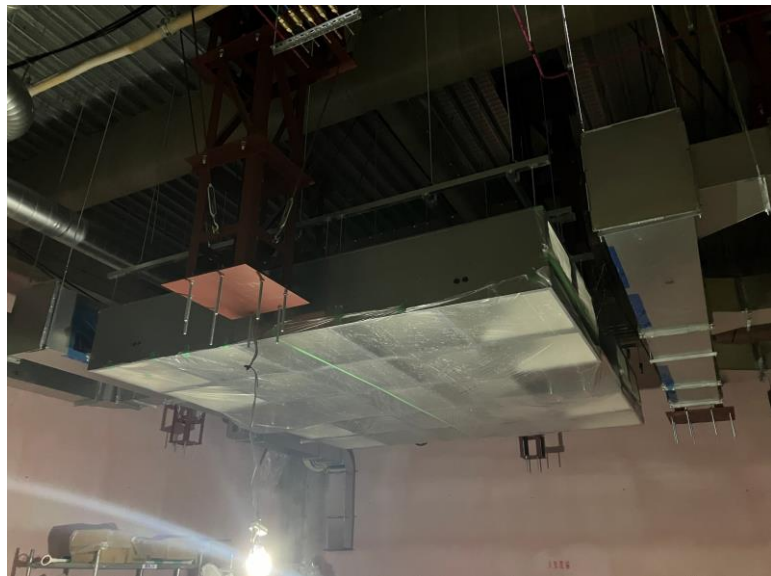
写真⑬(機械工事 5階手術室施工状況)
