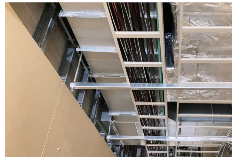
写真⑯(電気工事 4階幹線ケーブル敷設状況)
