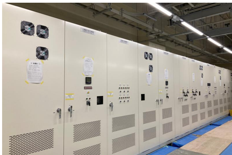
写真⑮(電気工事 1階受変電設備機器設置状況)
