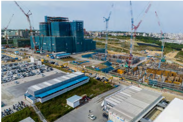
写真⑨(北東側)
