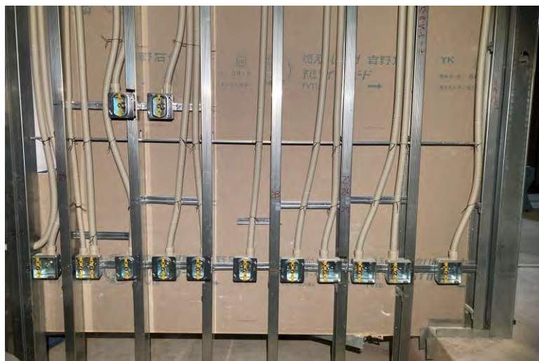
写真⑮(電気工事 BOX建込状況)
