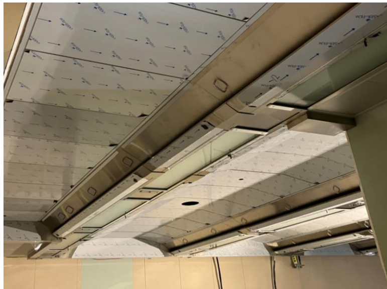
写真⑬(機械工事 厨房天井換気システムパネル取付状況)
