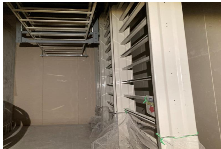
写真⑯(電気工事 縦ラック設置状況)
