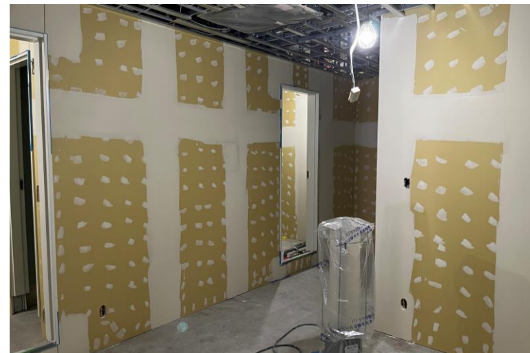
写真⑫(塗装工事 1階パテしごき施工状況)
