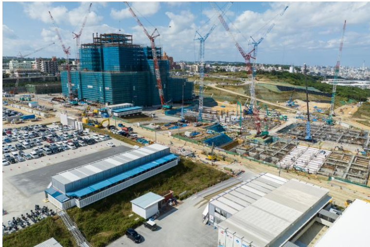
写真⑨(北東側)
