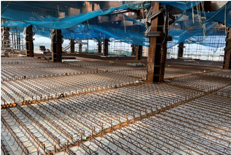
写真⑪(型枠工事 12階デッキ施工状況)
