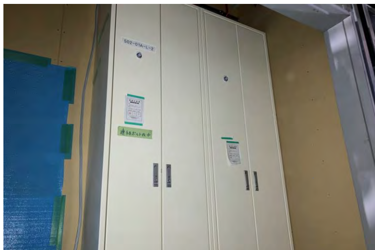
写真⑮(電気工事 1階電灯盤設置状況)
