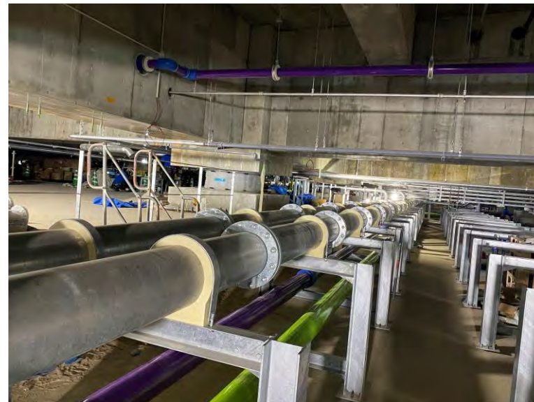
写真⑭(機械工事 免震階 配管施工状況)
