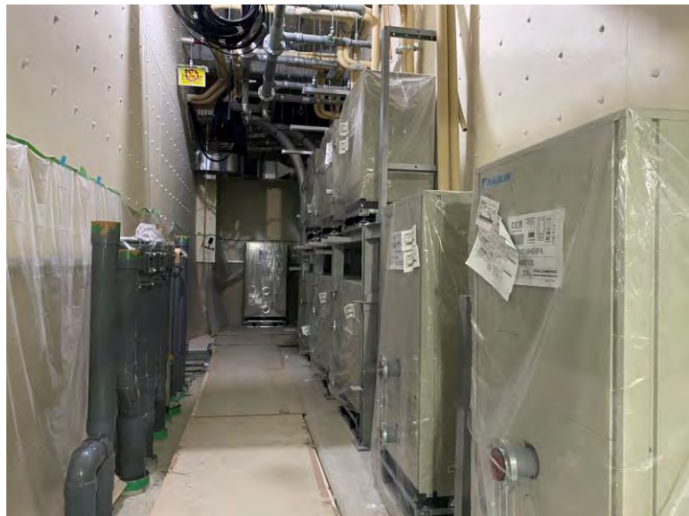
写真⑬(機械工事 1階天井内施工状況)
