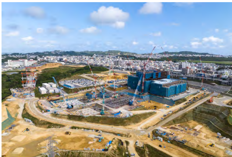
写真⑦(北西側)
