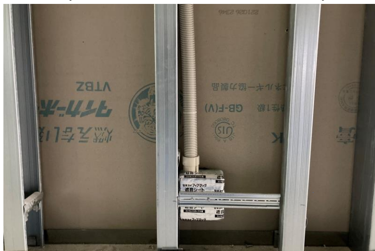
写真⑮(電気工事 1階 遮音BOX取付状況)
