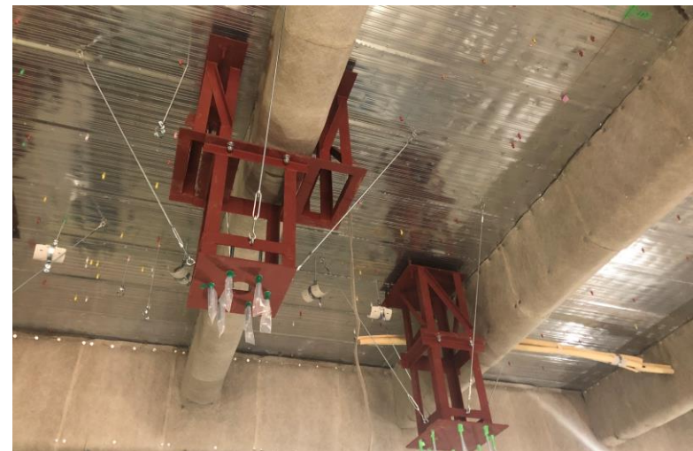
写真⑫(鉄骨工事 2階無影灯架台施工状況)
