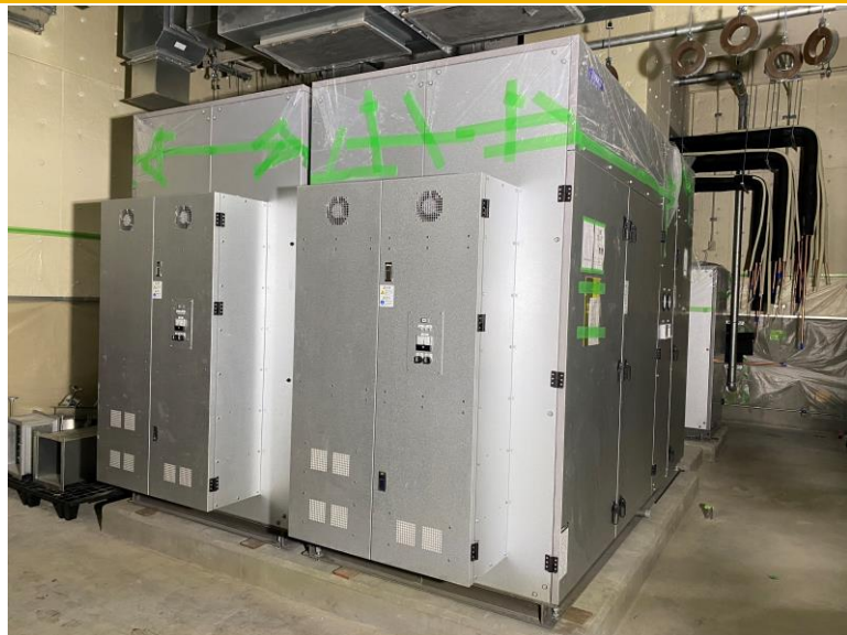
写真⑬(機械工事 1階空調機搬入据付状況)
