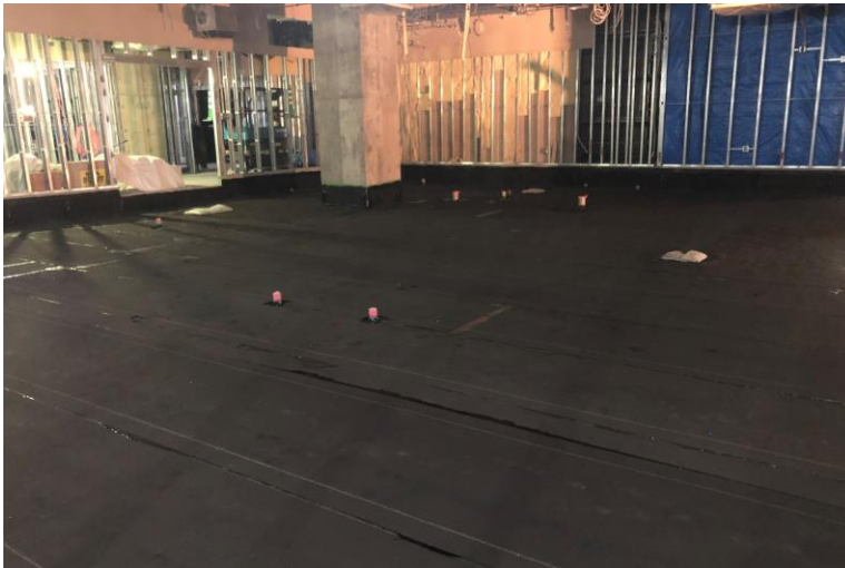
写真⑪(防水工事 1階アスファルト防水施工状況)
