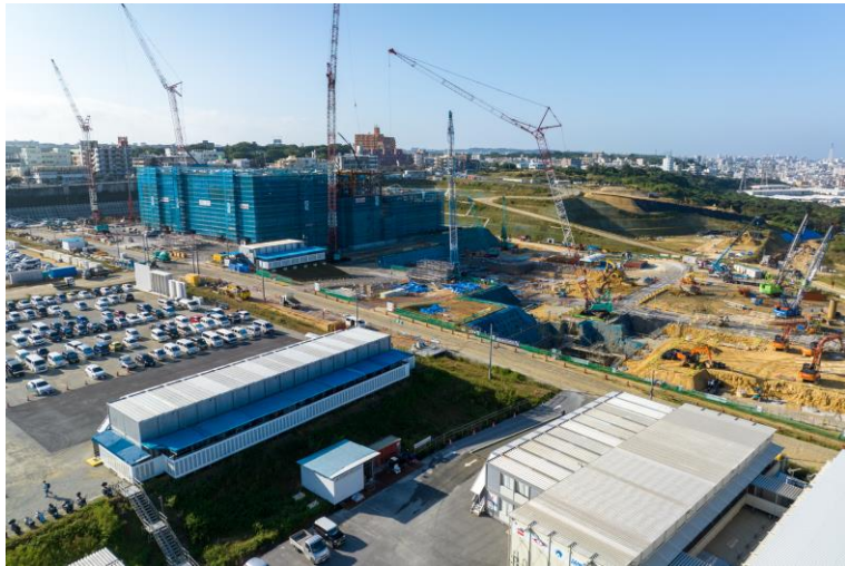
写真⑨(北東側)
