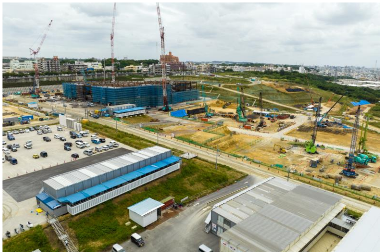
写真⑨(北東側)
