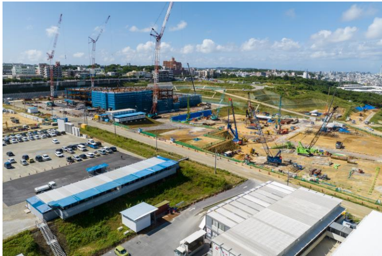
写真⑨(北東側)
