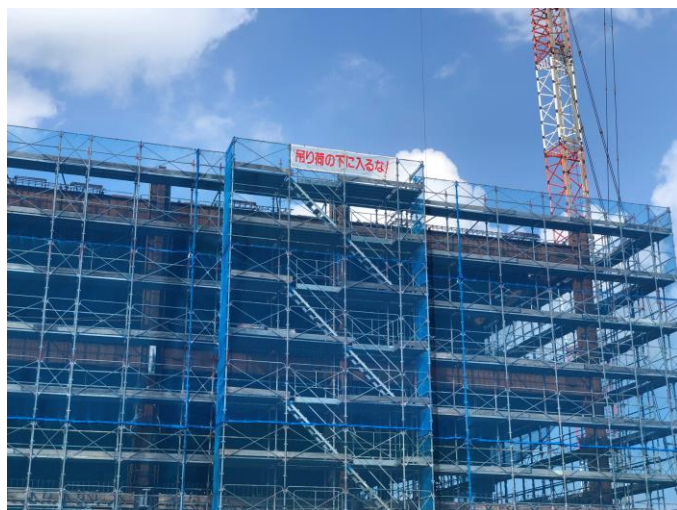
写真⑬(東側外部足場組立状況)
