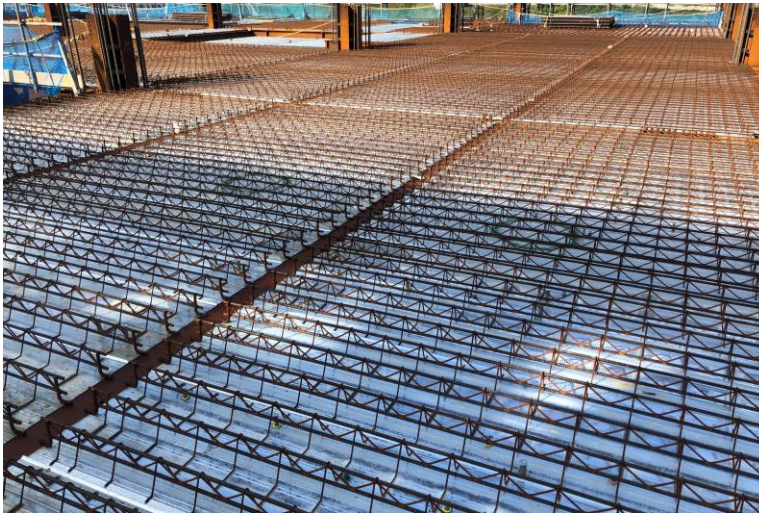
写真⑪(型枠工事 4階デッキスラブ施工状況)
