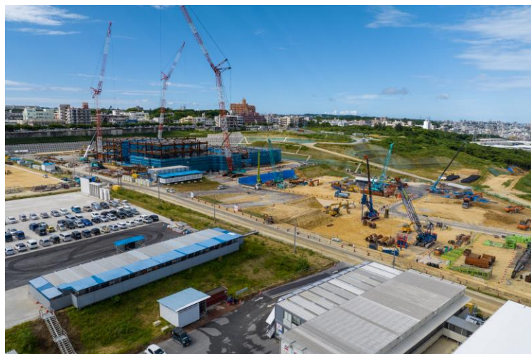
写真⑨(北東側)
