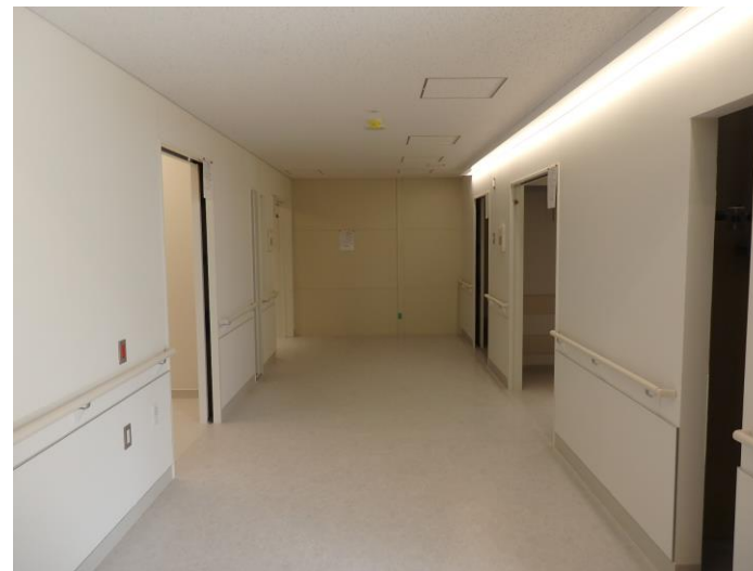
写真⑫ (モデルルーム工事 内装仕上施工状況)
