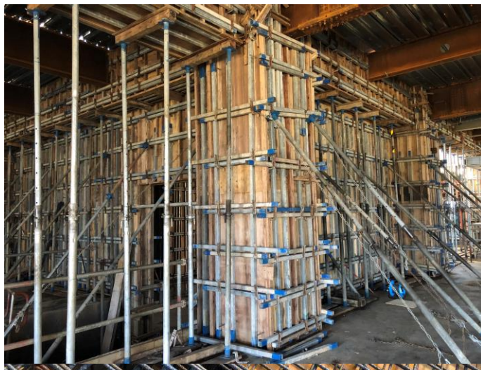
写真⑪(型枠工事 1階柱型枠施工状況)
