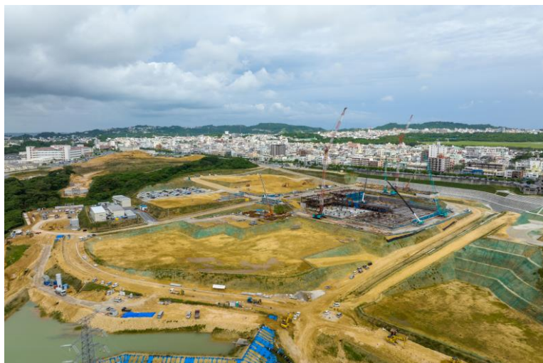
写真⑦(北西側)
