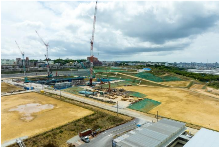
写真⑨(北東側)
