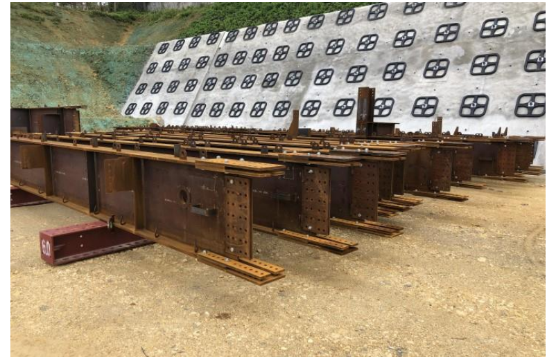
写真⑫(鉄骨工事 2階鉄骨梁搬入状況)
