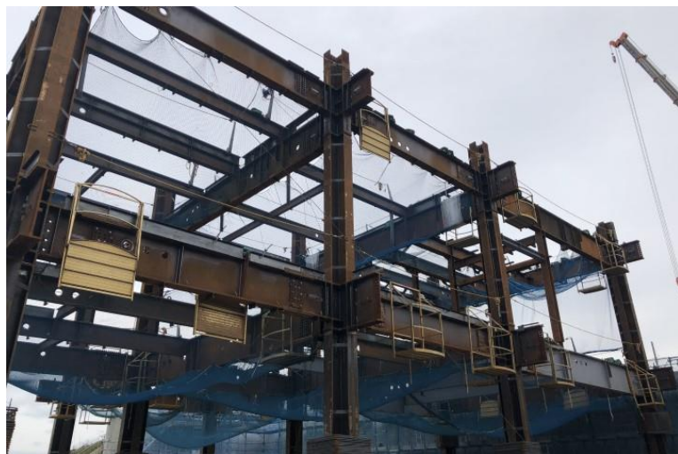
写真⑬(鉄骨工事 1節鉄骨建て方状況)
