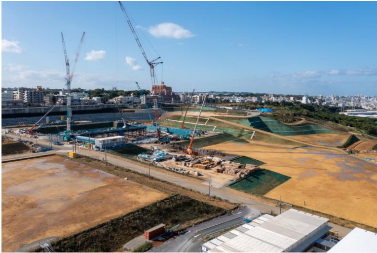
写真⑨(北東側)
