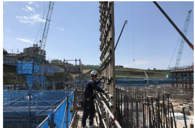
写真⑫ (型枠工事 擁壁型枠施工状況)
