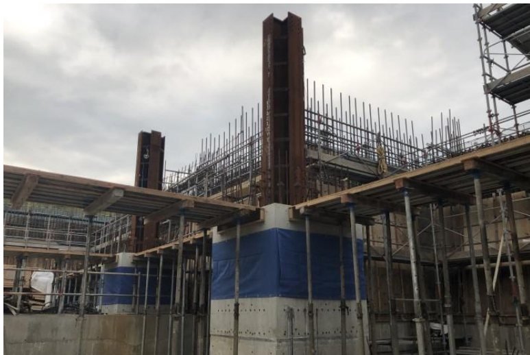
写真⑪(鉄骨工事 免震階鉄骨柱施工状況)
