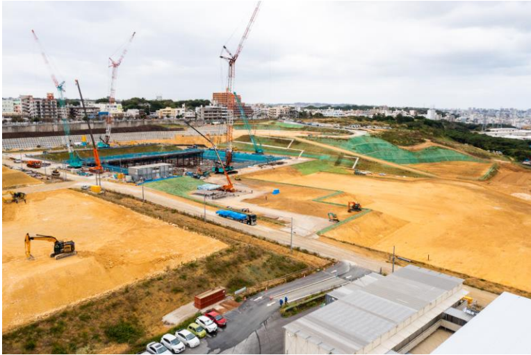
写真⑨(北東側)
