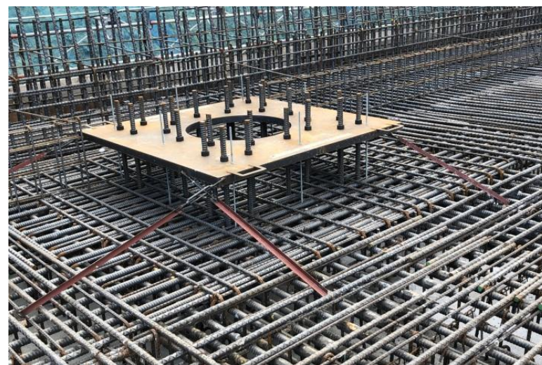
写真⑫ (鉄筋工事 免震層配筋状況)
