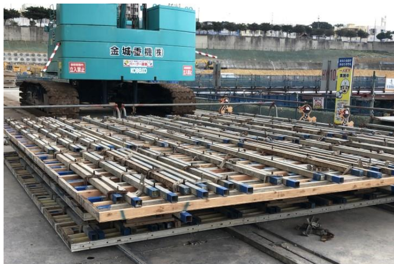
写真⑪(型枠工事 擁壁型枠地組状況)
