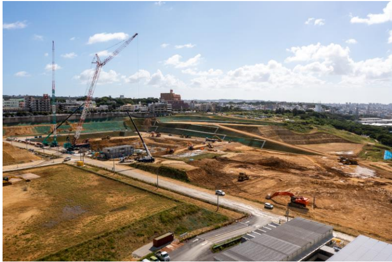
写真⑨(北東側)
