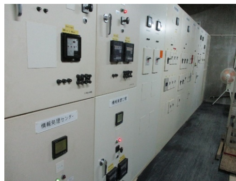
工4号館電気室（改修前）
