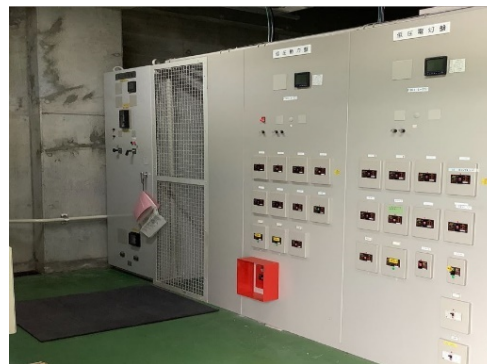
本部管理棟電気室（改修前）
