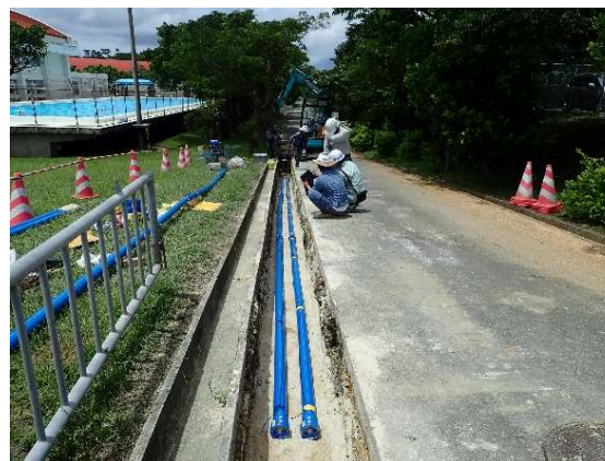
ポリエチレン管敷設状況
