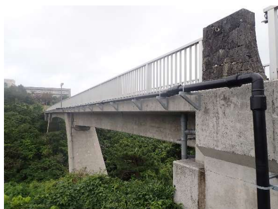
球陽橋配管状況
