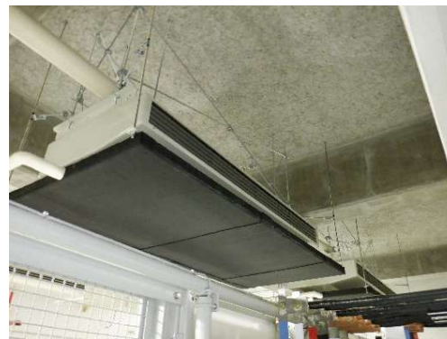
改修後 室内機
