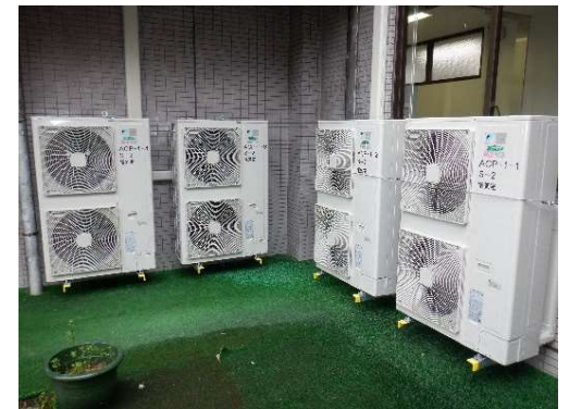
改修後 室外機
