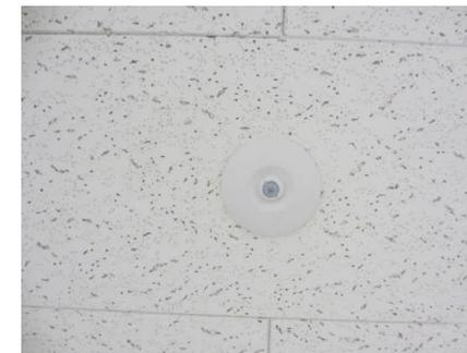
廊下の人感センサー：人を感知した時だけ点灯します
