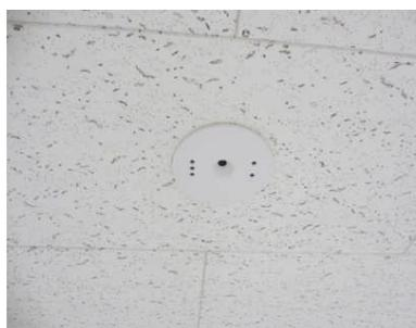
昼光センサー：外光を感知して窓際の照明の明るさをコントロールします
