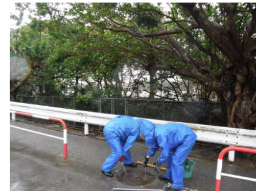
附属小中学校系統排水管調査状況
