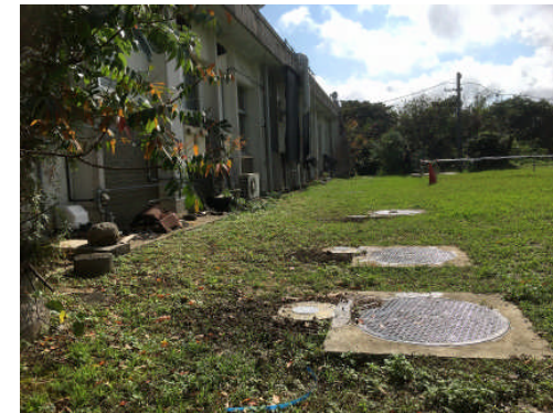
農場管理棟裏の補修した生活排水系塩ビマンホール蓋(補強済み)
