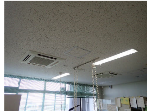
理系複合棟 空調室内機 (改修前：5階事務室)
