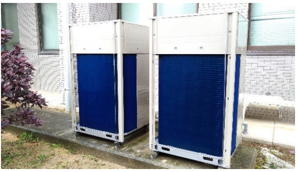
改修後 室外機
