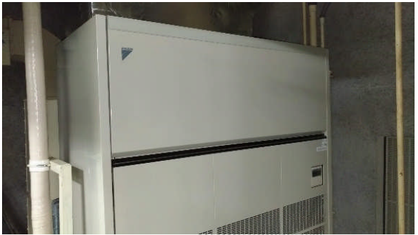
改修後 室内機
