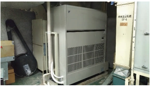
改修後 室内機
