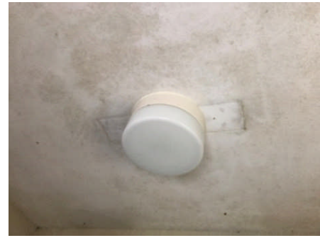
共用部 階段灯（改修前）
