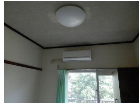
寝室 蛍光灯（改修前）
