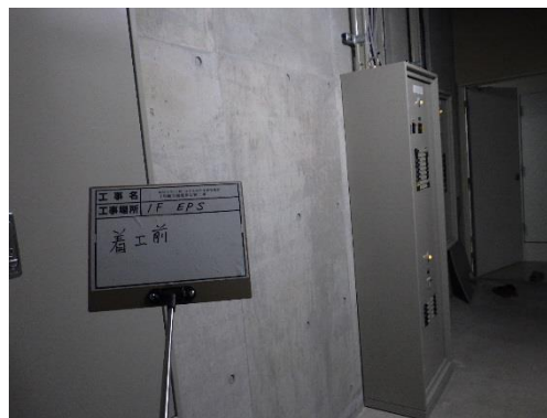
1階EPS分電盤設置前
