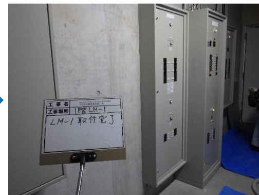
1階EPS分電盤設置後
