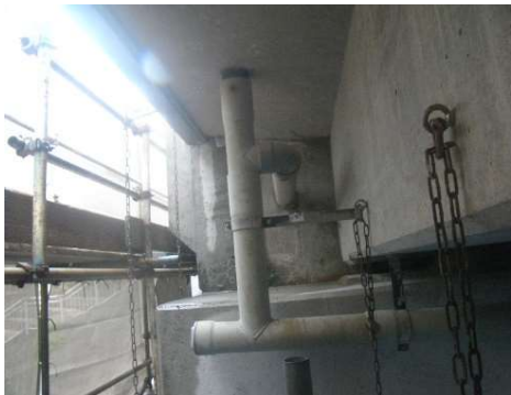
改修前：球陽橋
