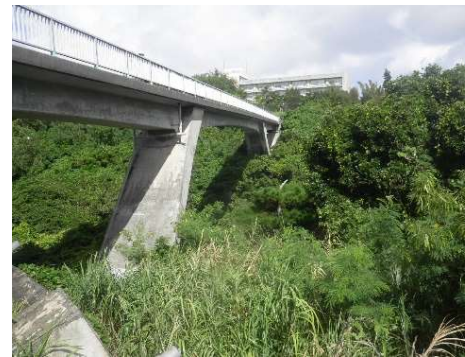
改修前：球陽橋
