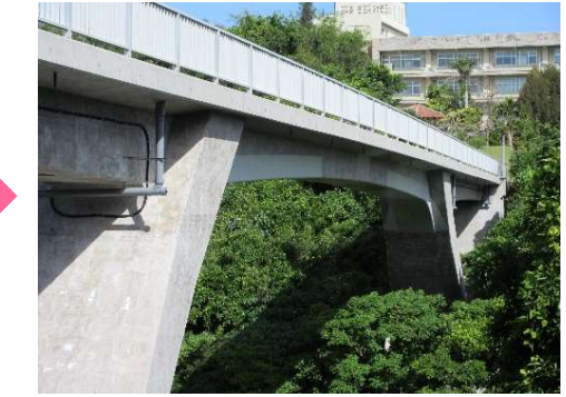
改修後：球陽橋 炭素繊維
