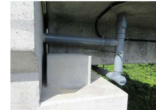
改修後：球陽橋 横変位拘束構造設置
