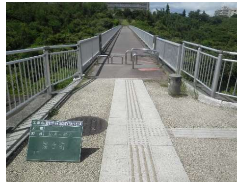
改修前：球陽橋アスファルト舗装
