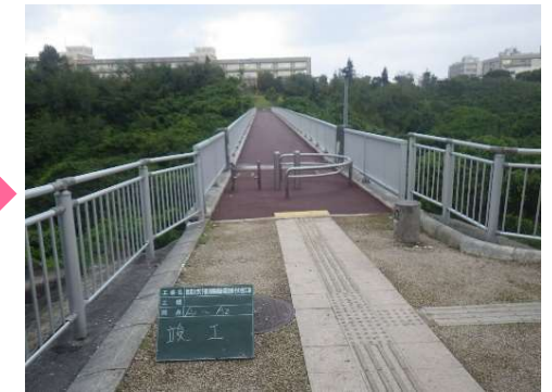
改修後：球陽橋アスファルト舗装（不透水性）
