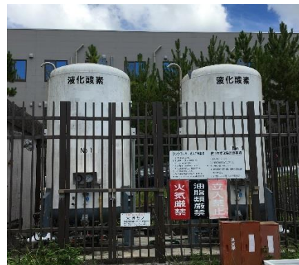
改修前（液体酸素貯槽）
