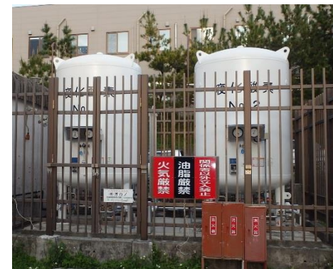
改修後（液体酸素貯槽）
