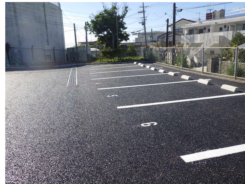
〔改修後〕駐車場
