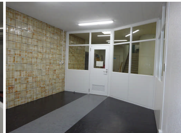
【理学部別館】 学生控室 (改修後)
