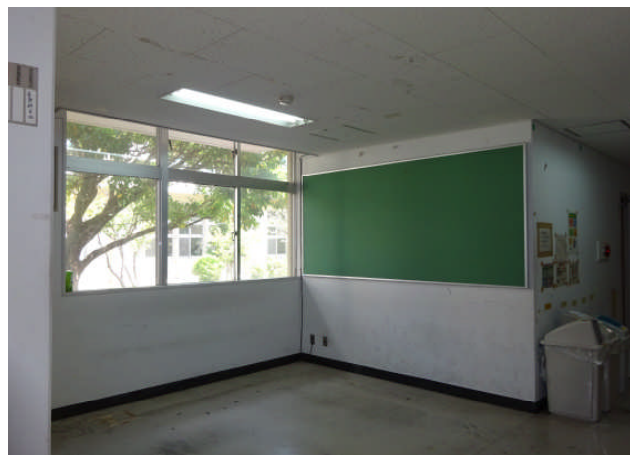
【音楽棟】 学生控室・練習室→学生控室 (改修前)
