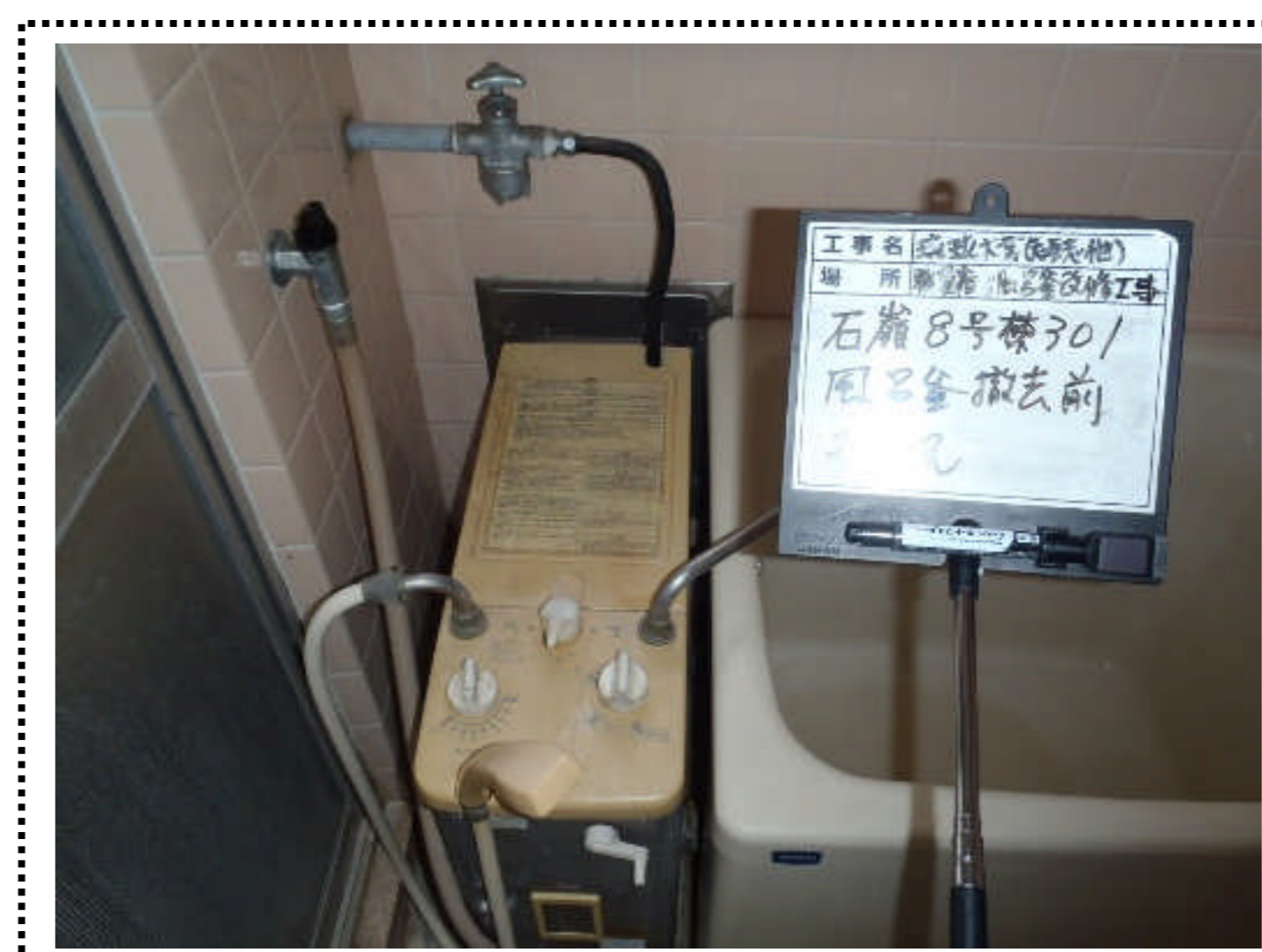
(改修前) 石嶺宿舎
