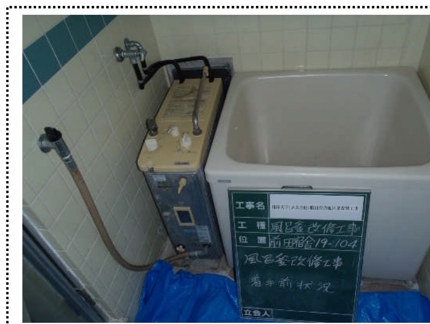
(改修前) 前田宿舎
