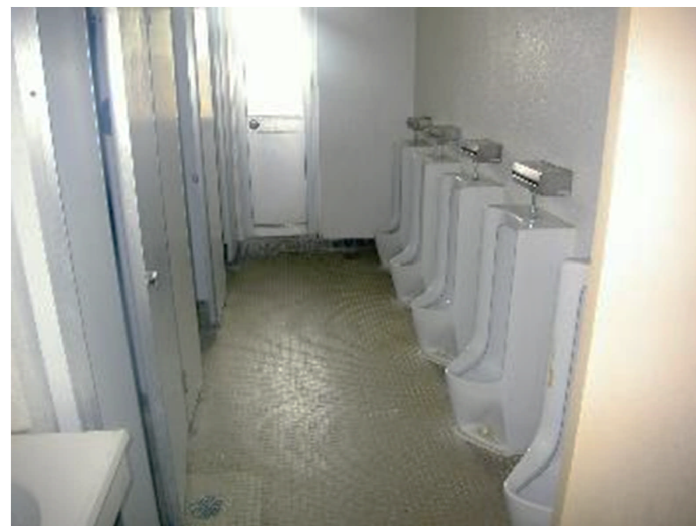
2～4F男子トイレ〔改修前〕
