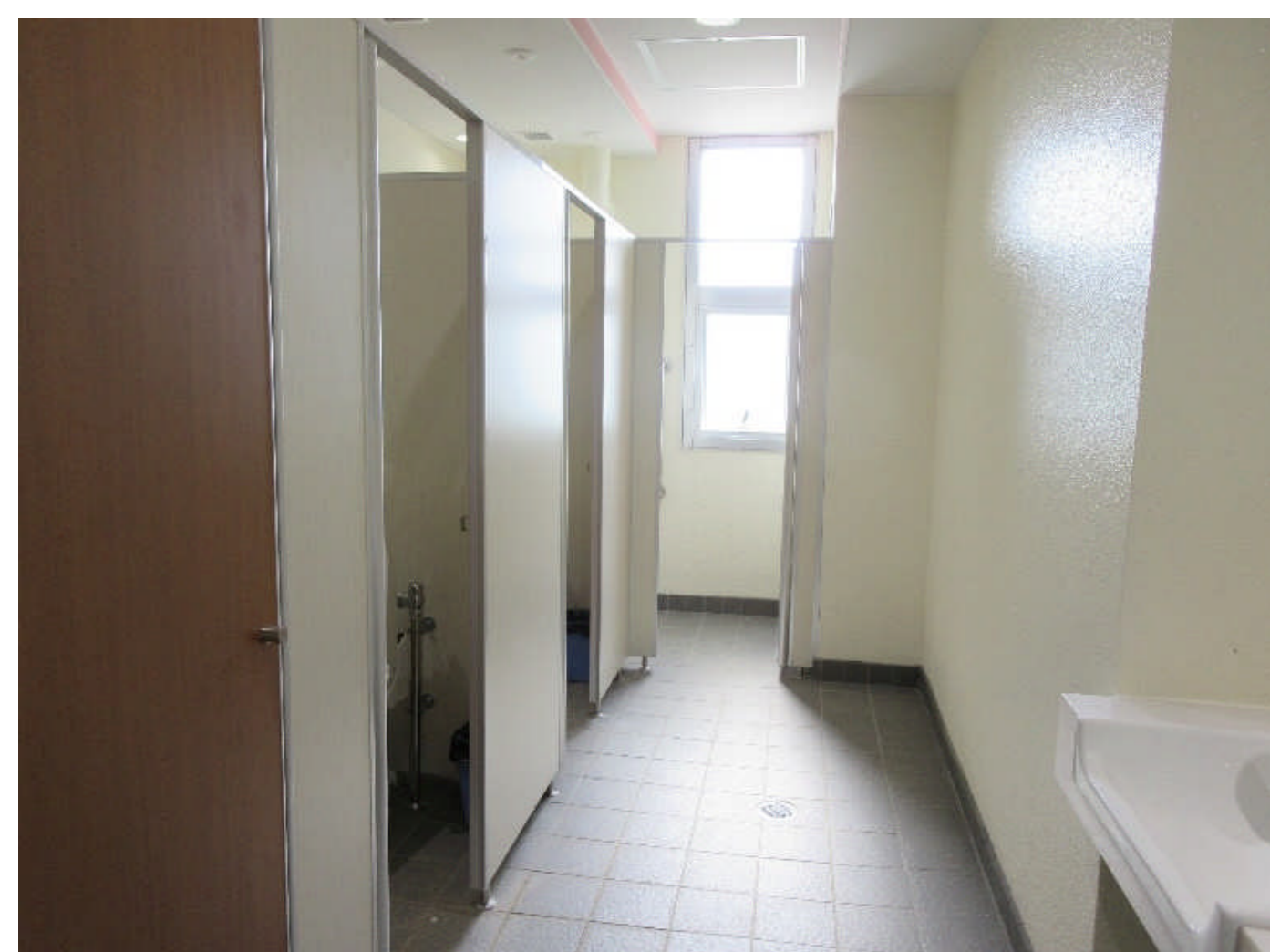
1F女子トイレ〔改修後〕
