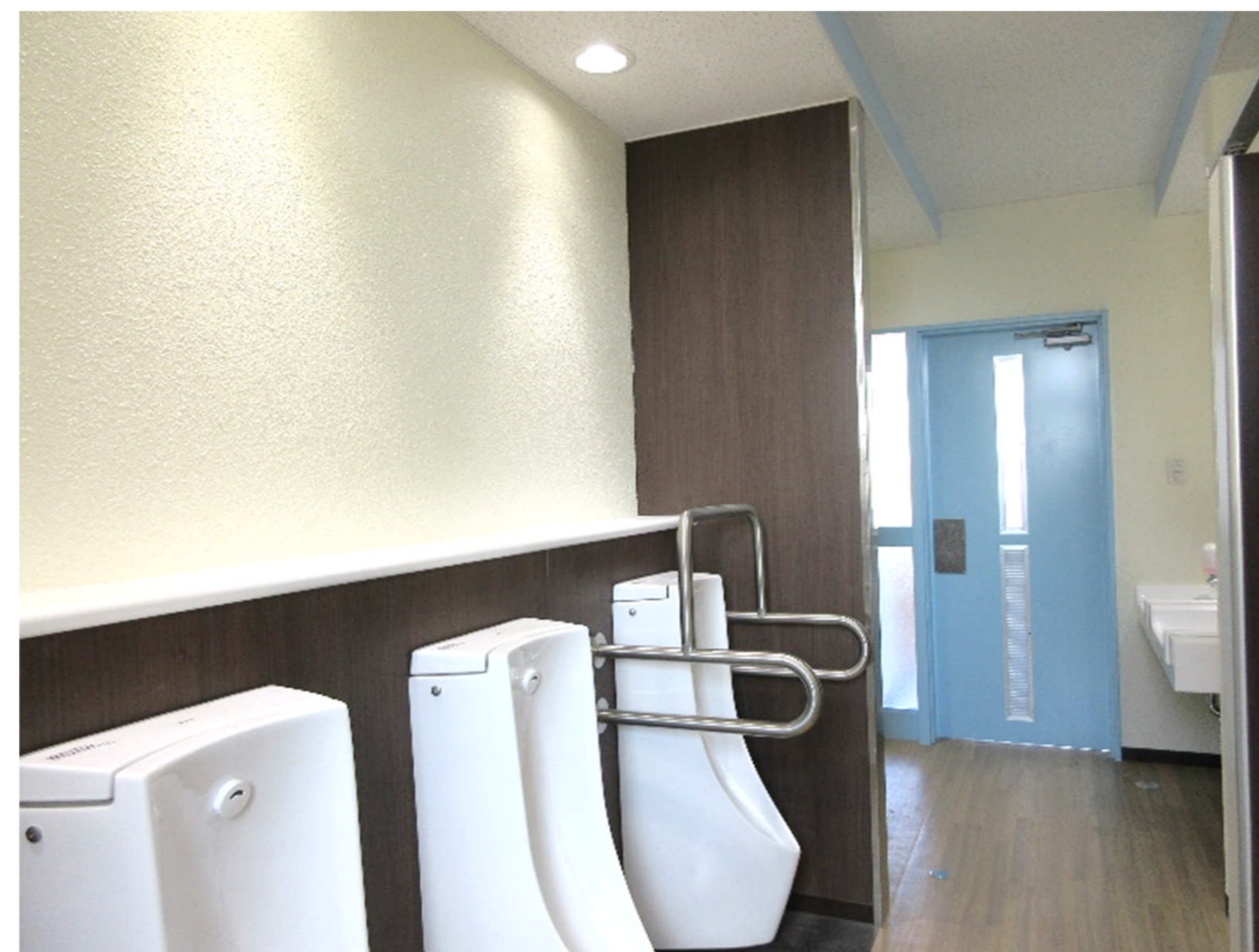
2～4F男子トイレ〔改修後〕
