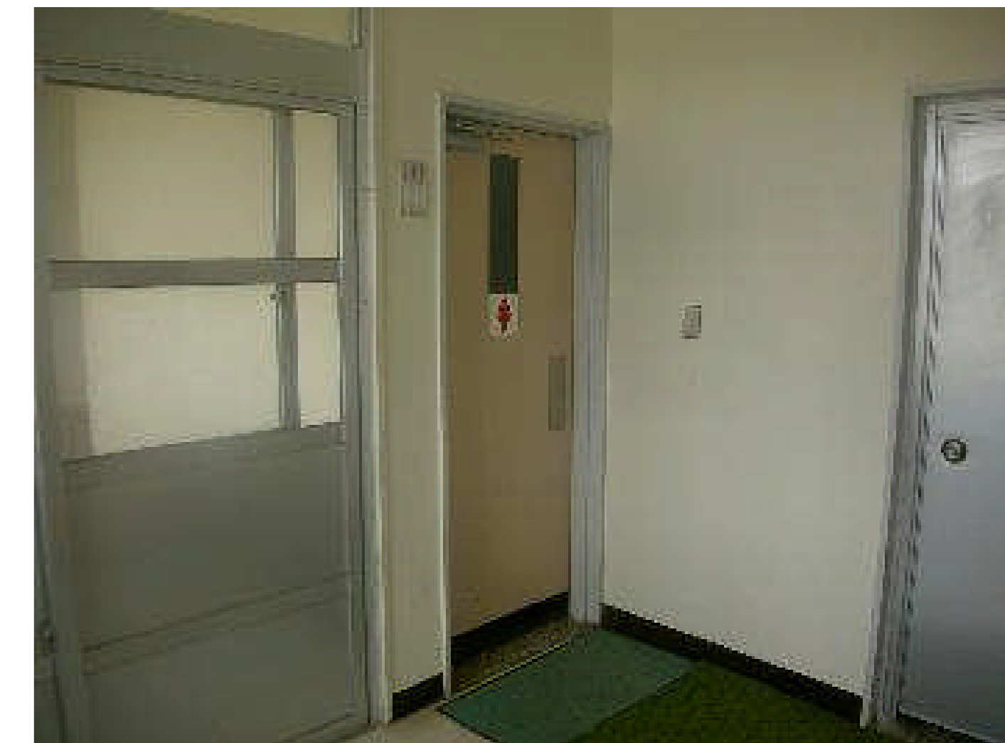
トイレ出入口〔改修前〕
