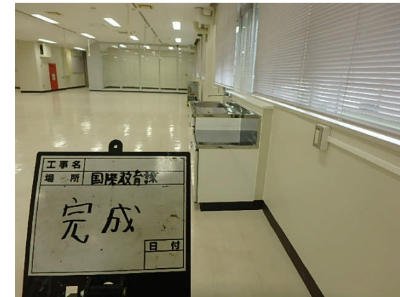
▲共通教育棟1号館 スタディールーム→事務室〔改修後〕
