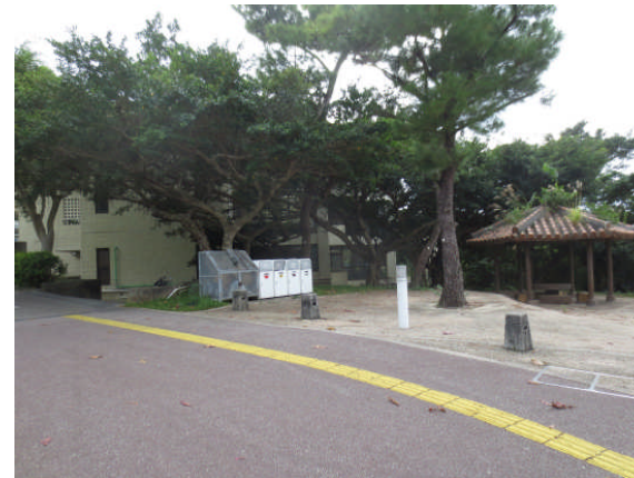
▲大学会館 外構〔改修前〕
