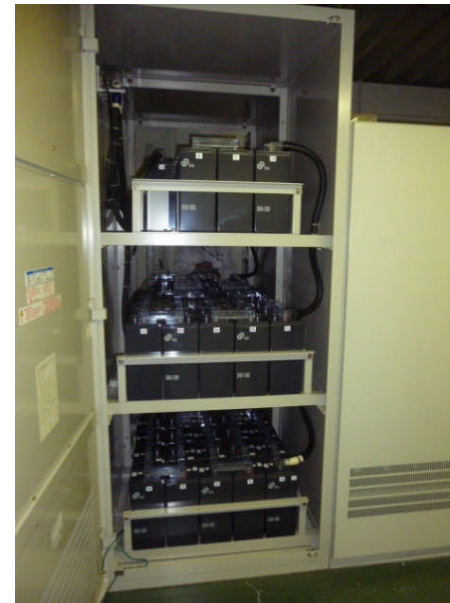
附属病院直流電源設備 （改修前）
