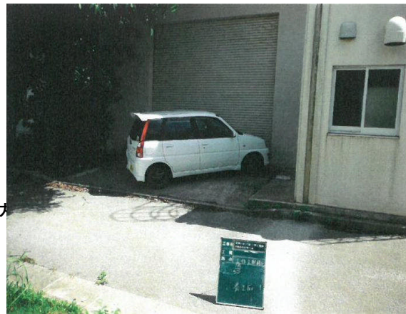
改修前(工作工場棟B)
