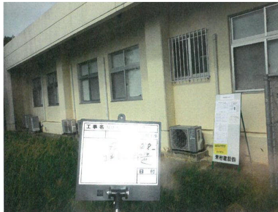
改修前(極低温センター)
