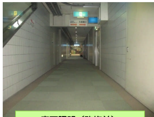
廊下照明(改修前)
