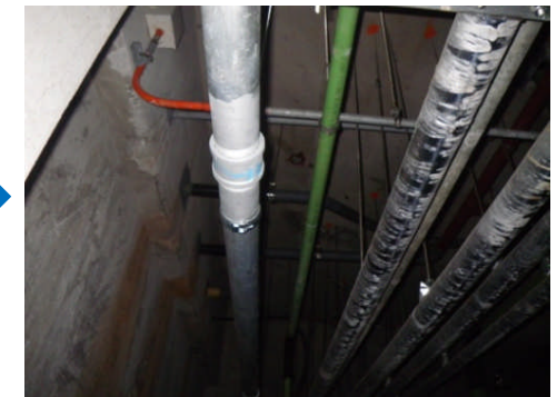
配管全体更新
