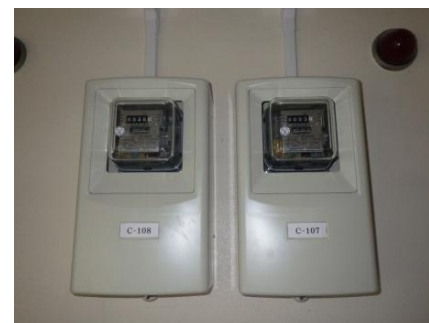
紫陽花棟 電力量計 更新後
