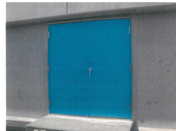
改修後(理系複合棟)
