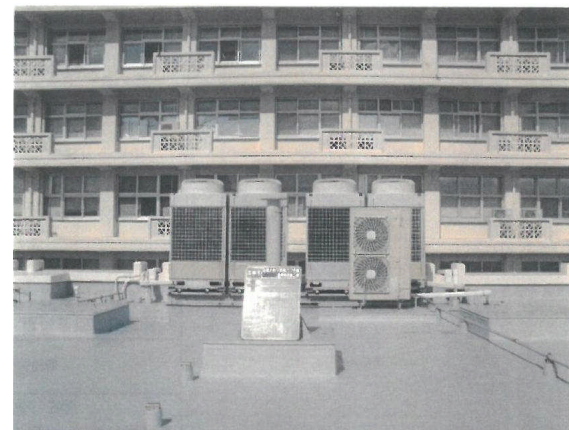
改修前(総合情報処理センター)
