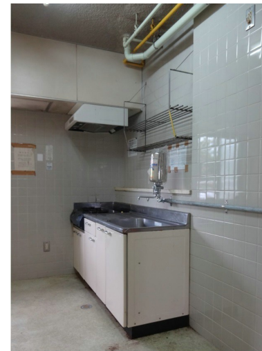
補食室改修前写真
