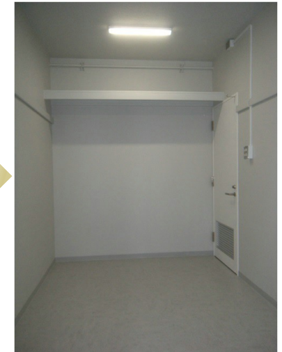
居室改修後写真
