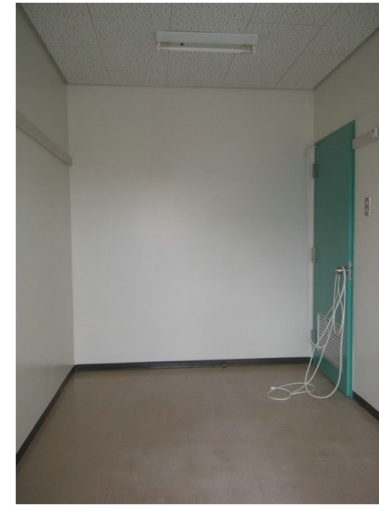
居室改修前写真
