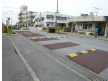
北口減速帯 (バンブ) の設置
